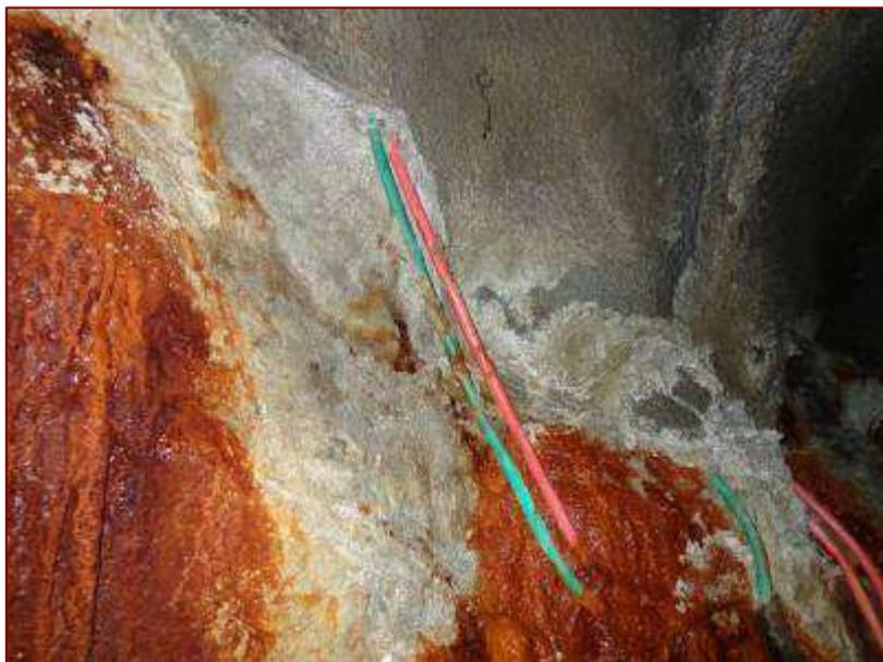
*Foto 5.4-8: esempio dei rudimentali drenaggi posti in opera sotto il rivestimento di spritz-beton*
