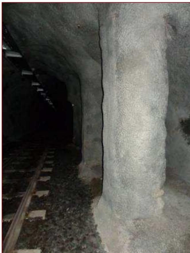
*Foto 5.4-7: colonne in muratura inutilmente rivestite con spritz-beton*
