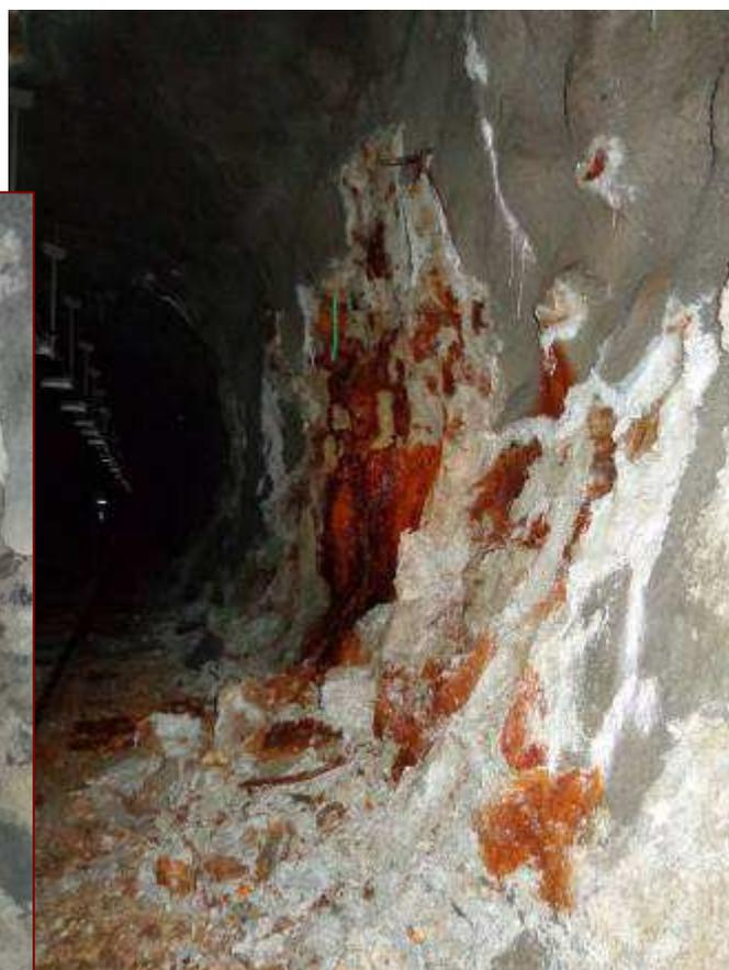
*Foto 5.4-5, 6: rivestimento in spritz-beton ammalo rato, a sinistra su rivestimento un muratura, a destra su roccia nuda*
